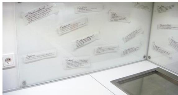
Nota del equipo de supermagnete: tenga en cuenta que el peso de la placa de vidrio se apoya sobre la guía de aluminio y no es soportada por los imanes. Los imanes tan solo mantienen la placa en su sitio para que no se vuelque. El vidrio empleado es demasiado grueso como para poder fijarlo a imanes.
