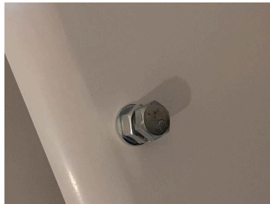
La vis sert de poignée pratique pour la trappe de visite.
