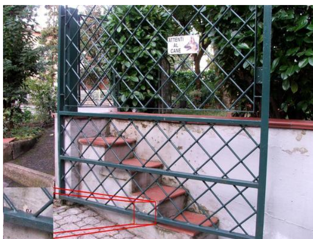
Portail ouvert - l'aimant en pot avec trou de fixation biseauté est marqué en rouge
