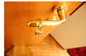
Parallelepipedo magnetico Q-20-20-10 inserito nel respingente
