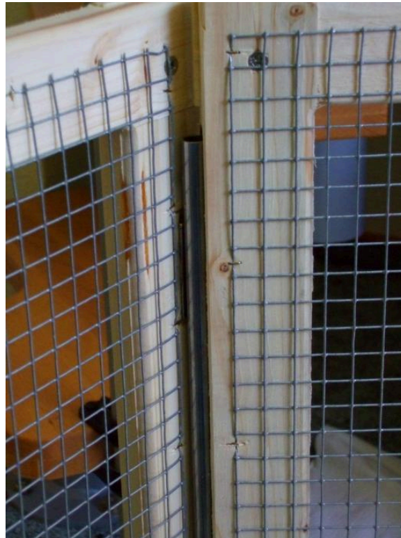
I magneti e il tubo aderiscono in maniera flessibile
